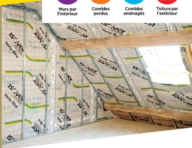
La membrane Vario® Xtra est composée d'un film polymère quadrillé contrecollé sur un voile non tissé. Sa résistance à la diffusion de la vapeur d'eau (Sd) varie en fonction de l'humidité relative, entre 0,4 m et 25 m. En hiver, son Sd élevé bloque la circulation de la vapeur d'eau de l'intérieur vers l'extérieur. En été, son Sd faible favorise la circulation de la vapeur d'eau de l'extérieur vers l'intérieur et permet le séchage des parois.
