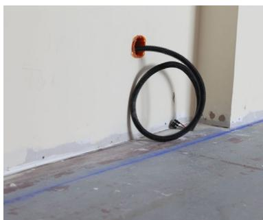
Tracer au « bleu » le plan de pose du parement et des lisses hautes et basses. Tracer la ligne qui correspond au niveau fini du futur doublage en enlevant l'épaisseur de la plaque de plâtre (13 mm pour une plaque standard). Autre façon de procéder : tracer au sol une ligne parallèle au mur, de l'épaisseur de l'isolant + 18 mm. Cette ligne constitue le plan de pose de la plaque de plâtre contre la lisse Clip'Optima. Projeter cette ligne au plafond à l'aide d'un niveau laser ou d'une règle.
