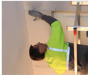
Ajouter des bouts de fourrures verticales en bordures latérales de l'imposte fixés contre la fourrure d'angle par des Connector pour permettre le vissage de la plaque de plâtre **6**.
