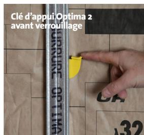
Clé d'appui Optima 2 avant verrouillage
