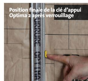
Position finale de la clé d'appui Optima 2 après verrouillage
