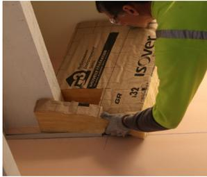
Tracer et fixer, au plafond les lisses Clip'Optima formant le plan de pose du parement **1**.
