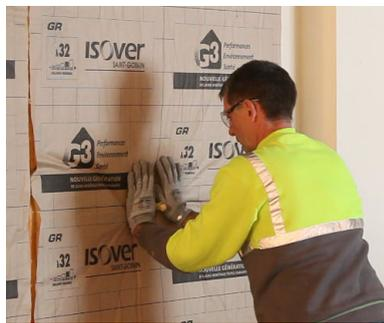
Embrocher l'isolant GR32 sur les tiges des appuis Optima 2. Contrôler la pose.
