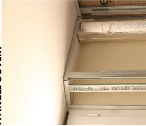
Positionner 2 segments de lisses Clip'Optima formant l'angle d'ouverture en plafond **4** et au sol **5** ou à niveau intermédiaire sur l'appui de fenêtre réalisé **1**.
