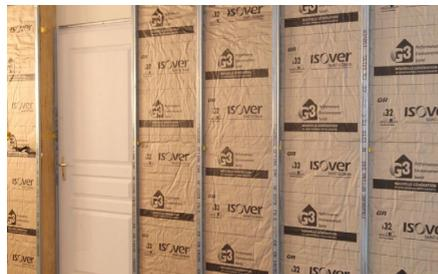
Les fourrures Optima 2 sont prêtes à recevoir, après réglage, leur parement en plaque de plâtre.
