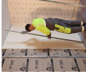
Mise en œuvre mixte d'un appui Optima 2 et de Connector Optima pour positionner et régler au même plan le parement du futur doublage 1 2. Embrocher l'isolant sur le mur décroché et placer des clés d'appui Optima 2 dans le prolongement des demis Connector Optima 2 3.
