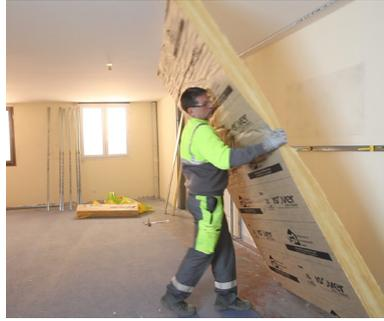
Mesurer la hauteur sous plafond. Reporter cette mesure sur l'isolant GR 32 déroulé en ajoutant 1 cm avant la coupe des lés d'isolant (lés = longueur d'une découpe). Ce cm supplémentaire assure un calfeutrement idéal.
