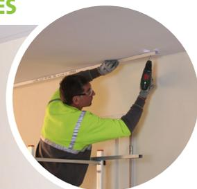
Positionner la face avant plate de la lisse Clip'Optima sur la ligne tracée. Fixer la lisse basse selon la nature du sol au moyen de fixations adaptées. Prévoir un point de fixation tous les 60 cm maximum. Répéter l'opération pour la lisse haute au plafond.
