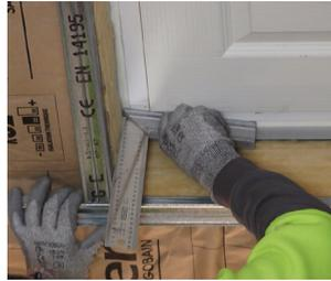
Poser un Connector Optima sur les fourrures verticales aux angles supérieurs du passage de porte **2** avant la pose d'une fourrure horizontale clipsee sur les Connector **3**.
