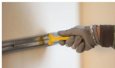
Clipser la tige de l'appui Optima 2 sur la fourrure horizontale. Placer un appui tous les 60 cm.
