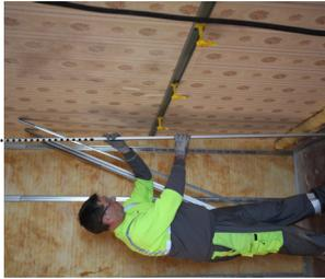
Fixer des lisses Clip' Optima hautes et basses à une distance supérieure à l'épaisseur de la plomberie existante, largeur des colliers inclus **2**.
