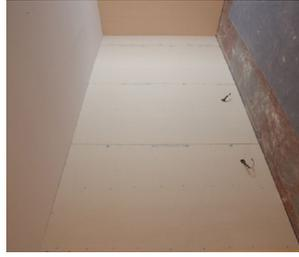
Si cette partie du mur est contiguë à un local chauffé, il est possible de ne pas mettre d'isolant. Sinon un isolant de faible épaisseur peut être placé entre les fourrures 5.
