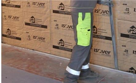
Encastrement de la fourrure Optima 2 dans la lisse basse Clip'Optima.
