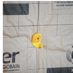
3. Verrouillage provisoire pour la maintenir en place par rotation 1/4 de tour.
