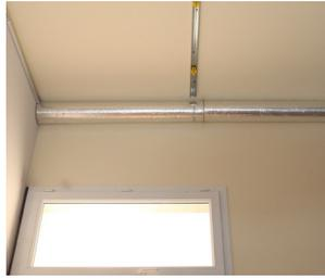
Recouvrir le tuyau PVC avec un isolant Isolair en spirale du sol au plafond ou avec les coquilles pré-incisées, coquille Protect 1000 1.
