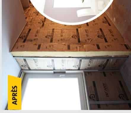
Mise en œuvre avec 2 fourrures verticales assemblées par 4 Connector.
