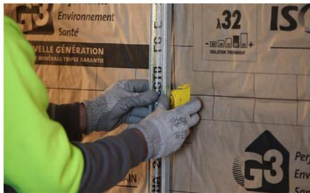
Clipsage de la fourrure sur la tête de la clé d'appui Optima 2.
