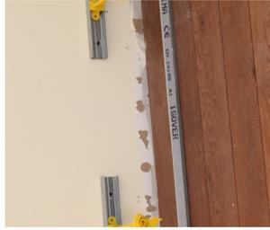
Pose classique d'une fourrure murale à 1,35 m de haut. Prévoir des petits segments de fourrures murales tous les 40 ou 60 cm **1** à poser à 5 à 10 cm du sol avec clipsage d'un appui Optima 2 **2**. L'écartement de 40 ou 60 cm dépend du type de revêtement sur les plaques de plâtre.
