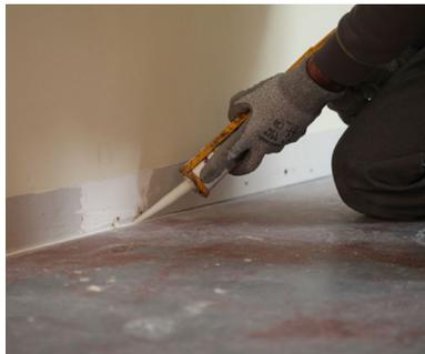
Enlever le revêtement de sol, les plinthes et prolonger les gaines et les câbles électriques pour les déplacer si besoin est. Occulter les fissures pour contribuer à l'étanchéité à l'air.
