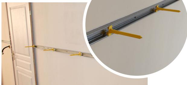
Ensemble d'appuis Optima 2 sur fourrure horizontale avant pose de l'isolant.
