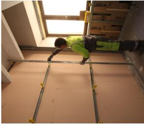
Tracer et fixer au mur les fourrages horizontales Optima tous les mètres **1** jusqu'au plafond. Fixer au sol les lisses Clip'Optima au plafond ou en rampant selon configuration **2**.
