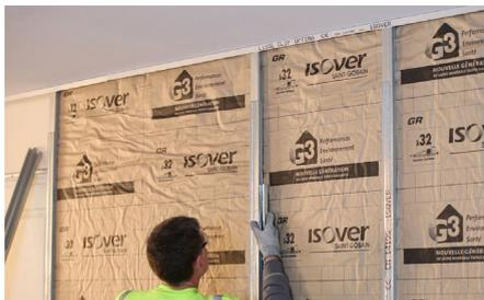
Encastrement de l'éclisse Optima dans la lisse haute Clip'Optima.
