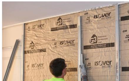
Coulissement de la rallonge Optima de la fourrure, jusqu'à la hauteur voulue avec une longueur de recouvrement minimale de 10 cm.
