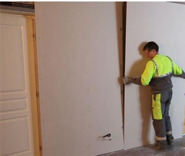
Les plaques de plâtre sont découpées à la hauteur sous plafond moins 1 cm. La première plaque est posée contre les fourrures et maintenue contre le plafond.
