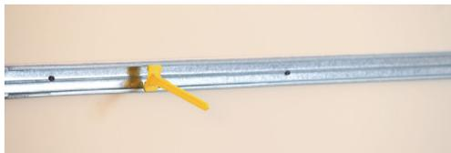
La position des appuis correspond au futur emplacement des fourrures verticales. Elles servent de support au parement en plaques de plâtre.
