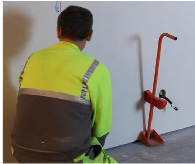
Réhaussement et maintien de la plaque à 1 cm au-dessus du sol et vissage sur les fourrures à l'aide d'une cale ou d'un lève-plaque.
