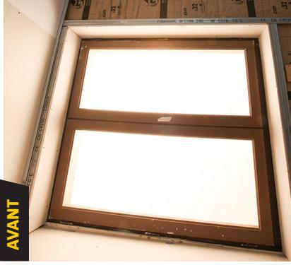
Vue de l'ossature avec l'isolant en place. Les tableaux sont habillés du parement en plaître de plâtre.
