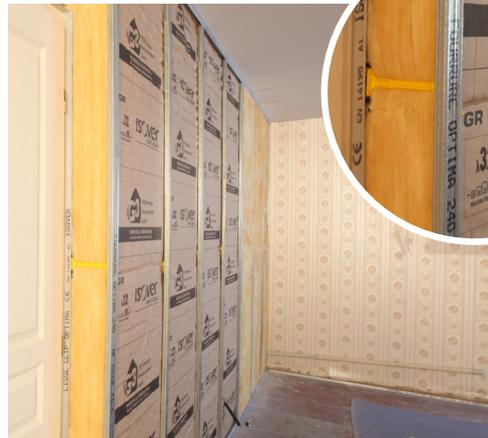
À chaque jonction, la clé d'appui est clipsée sur l'intérieur de la fourrure. En partie basse, la fourrure est encastrée dans le profil de la lisse Clip'Optima préalablement fixée. En partie haute, la fourrure (2,40 m) sera prolongée par une rallonge coulissante pour atteindre la hauteur sous plafond voulue. Elle s'encastrera dans le profil de la lisse Clip'Optima.
