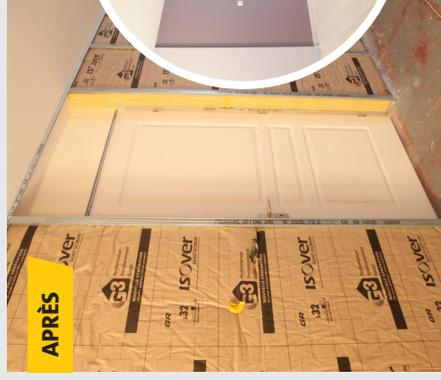
L'isolant est posé, hormis sur l'imposte. Les fourrures Optima sont visibles en encadrement sur les arêtes de passage de la porte.
