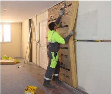
Commencer par caler l'isolant derrière la lisse basse Clip'Optima. Ensuite plier légèrement le panneau de parement pour le caler en haut derrière la lisse haute. Terminer en appuyant au milieu de l'isolant pour l'embrocher sur la tige de l'appui.
