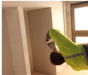
Poser la découpe de l'isolant au-dessus de la fenêtre **5**. Régler la fourrure d'arête **6**. Visser la découpe de plaque de plâtre face dessous **7**. Visser la plaque de plâtre en face avant **8**.
