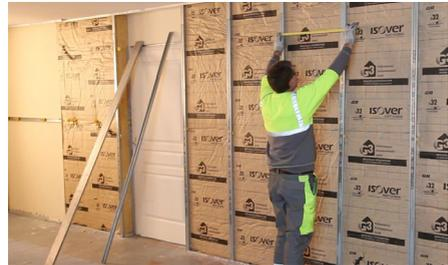
Contrôle de la planéité et de l'écartement des fourrures. Il faut vérifier le bon entraxe entre les fourrures (60 cm) pour que les bords des plaques de plâtre correspondent à l'axe des fourrures sur lesquelles elles seront fixées.
