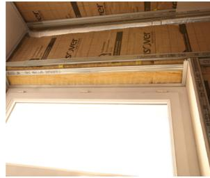
Placer des fourrures verticales au-dessus et sous la fenêtre, encastrées dans les lisses ou réunies avec les fourrures par des Connector.
