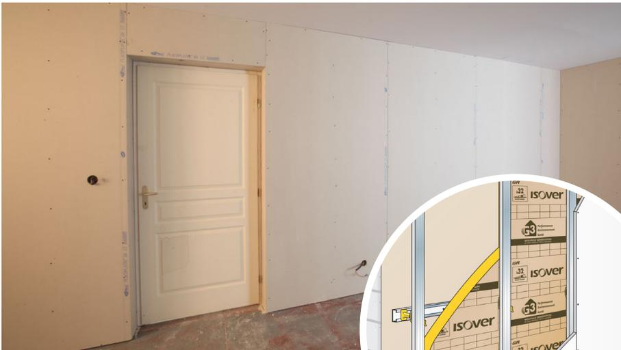
Une fois le parement fixé, il est conseillé de boucher les espaces en bordure des plaques par des joints souples acryliques à la pompe, ou un joint silicone en bas pour les pièces humides. Ensuite jointoyer et lisser entre les plaques avec un enduit « tout en un ». Le choix de plaques pré-peintes facilite les opérations de finition et de peinture.
