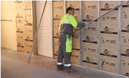
Vérification préalable de la planéité d'ensemble des fourrures avec une grande règle.
