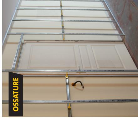
Vue de l'ossature métallique avec les lisses Clip'Optima en entourage de porte sans isolant.
