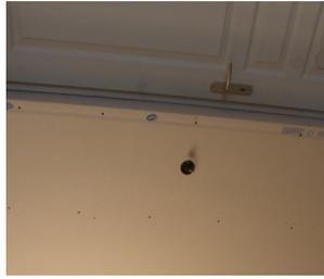
Sortie de circuit d'interrupteur 1 Percer la plaque de plâtre à l'emplacement de l'interrupteur 2 .
