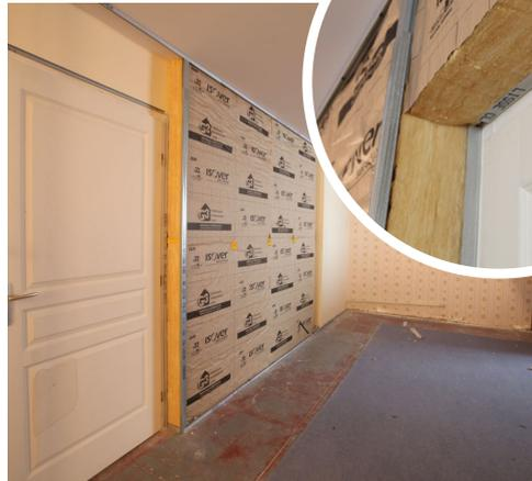
Dans le système Optima, l'isolant est séparé de la plaque de plâtre. Une fois l'isolant posé, il est possible de contrôler sa qualité de calfeutrement, sa continuité (sans espace entre les isolants). C'est l'assurance d'avoir une isolation performante et efficace avant la pose du parement plaque de plâtre.
