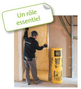
C'est la laine de verre qui joue le rôle d'amortisseur en diminuant l'amplitude du mouvement ondulatoire d'un son et réduit ainsi l'intensité de la transmission sonore.
